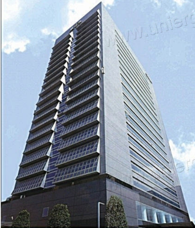
KYOCERA 京都企業總部 太陽光電併聯系統 裝置容量214kWp
