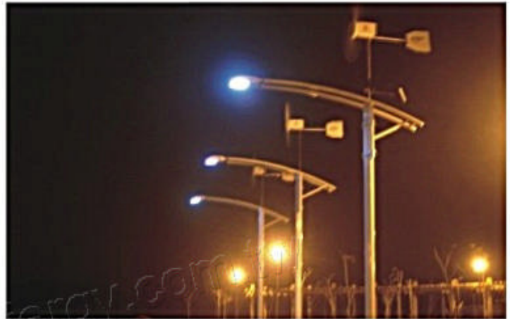
頭份垃圾掩埋場風力照明系統
