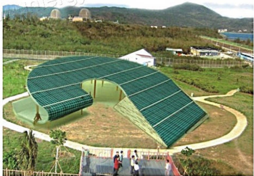
核三南展管50kWp BIPV系統示意(德國Abakus提供)
