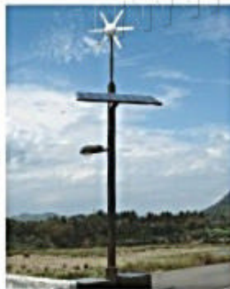
彰化縣氣象站20kW風力太陽光電混用系統
