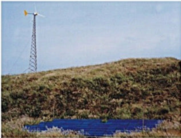
彰化縣氣象站20kW風力太陽光電混用系統
